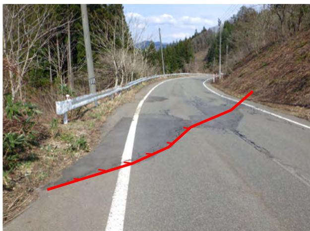
写真①: 路面の段差亀裂
