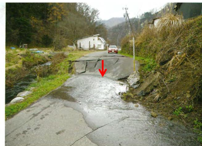
図-5 2016年長野県北部地震で生じた地震断層崖
